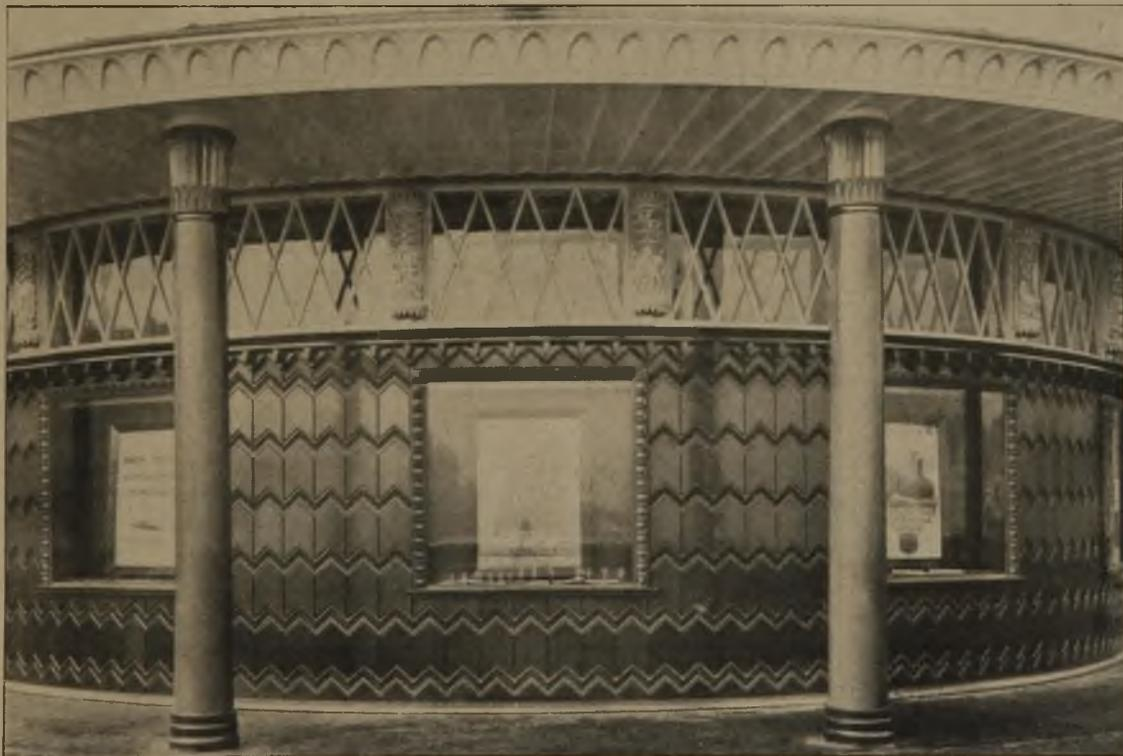
Abb. 9. Teil des Äußeren mit Umgang, Material (einschl. der Säulenschäfte): Holz.
